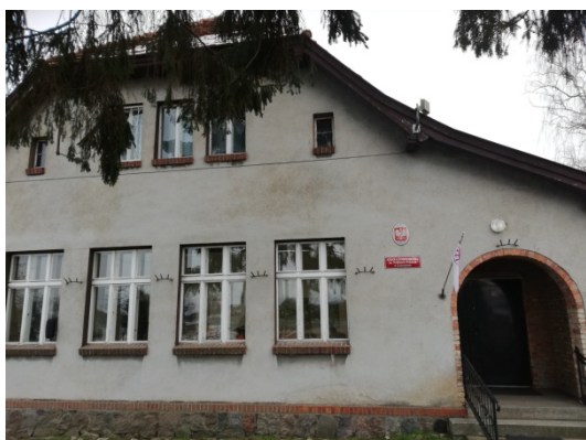
Zdjęcie nr 16 – Budynek Szkoły Podstawowej
