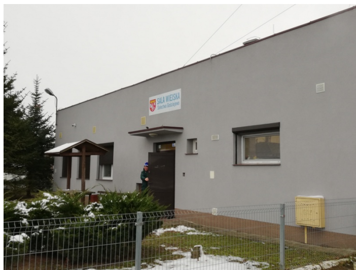
Zdjęcie nr 5 – Świetlica wiejska
