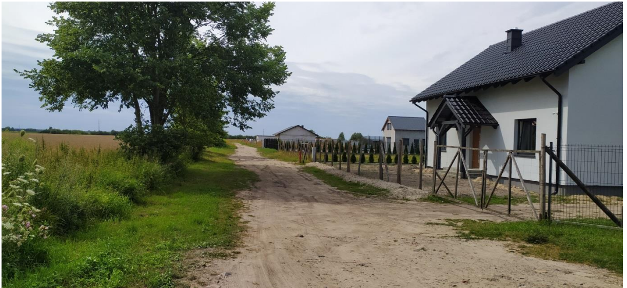
Fot. 1 Zabudowania nowego osiedla w Międzyzlesiu (obszar nr 1)
