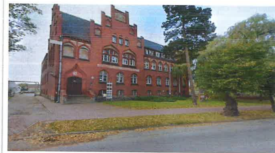
Fotografia 15 Budynek przy ul. Kościuszki 41 w Rogoźnie
